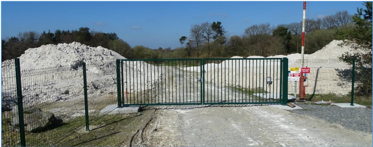
Fig. 8 : Vue sur l'accès au site, fermé par un portail
